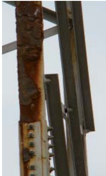
O estado das torres de transmissão de energia na Baixada Santista é bastante precário
