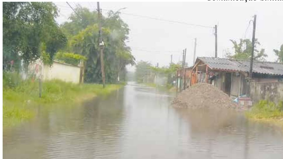
As constantes enchentes no local trazem riscos à saúde dos trabalhadores
